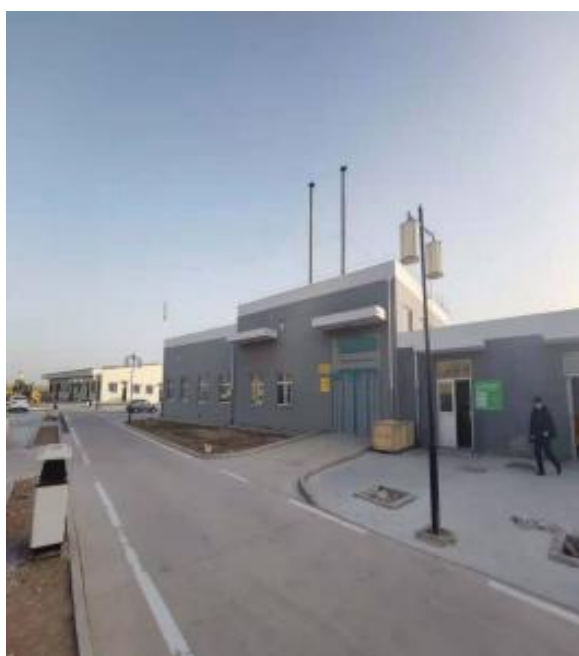
图 3-1 天然气锅炉排气筒
